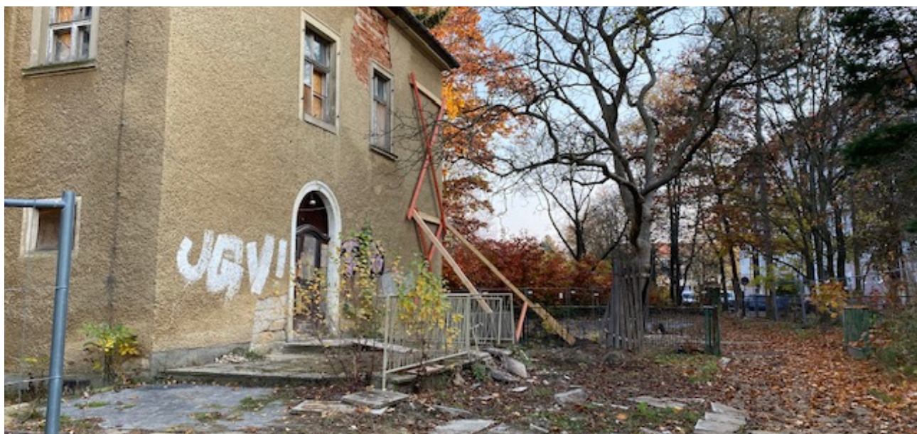
Die noch unsanierte „Villa Akazienhof“
